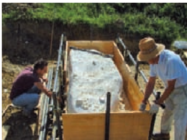
Fig. 5 - Operazioni di costruzione della gabbia metallica intorno al blocco inglobante il reperto.
