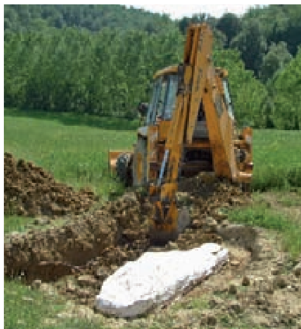
Fig. 4 - Operazioni di scavo intorno al sarcofago di gesso.
