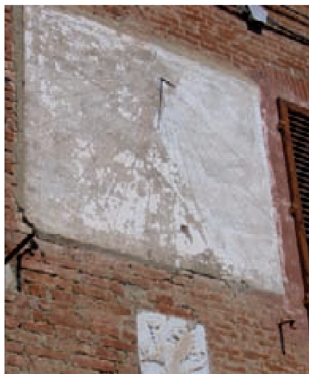
Fig. 3 - Orologio solare con stilo polare posto su un edificio di Lucignano d'Arbia (SI). Sebbene lo strumento necessiti di essere restaurato, vi si possono ancora leggere le ore vere del luogo, le linee dei solstizi e l'equinoziale.
