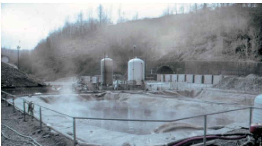
Fig. 4 - Le vasche di decantazione adottate per la depurazione delle acque di Campiano.
